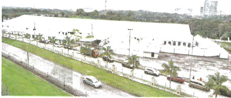
FASILITI baharu yang siap dibina boleh memuatkan sehingga 2,000 orang pesakit yang menerima rawatan di Pusat Kuarantin dan Rawatan Covid-19 di Maeps, Serdang semalam.
